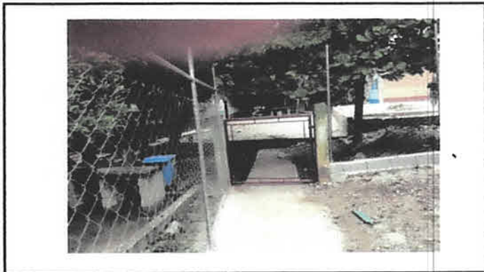
Foto 4: Mantenimiento de portones existentes , limpieza, refuerzo y pintura.
