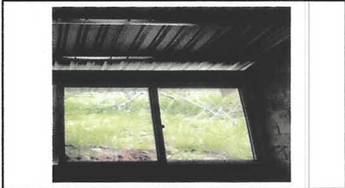
Foto 2: Instalación de ventanas de PVC.
