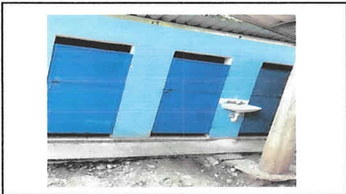
Foto 3: Mantenimiento de 3 baños y un lavamanos.
