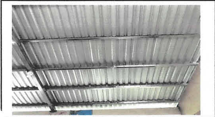
Foto1: Sustitución de techo y estructura metálica.
